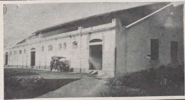
Aspecto das instalações e trabalhos do «Cortume Brazil», propriedade do sr. Firmino Costa, de Campinas: 1—A fachada do estabelecimento, construção moderna, com 70 metros de frente e com capacidade para trabalhar diariamente 150 couros vacuns e 200 pelles meudas. 2—A secção de descarnar couros. 3—O seccador de sola, comportando 4.000 couros. 4—A secção de cylindragem de sola. 5—A secção de tanques, com a machina de retirar os couros do banho, contendo 120 tanques e comportando 250 meios de sola.
